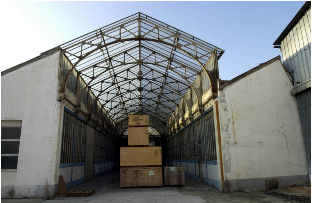
Verrière, vue ouest
