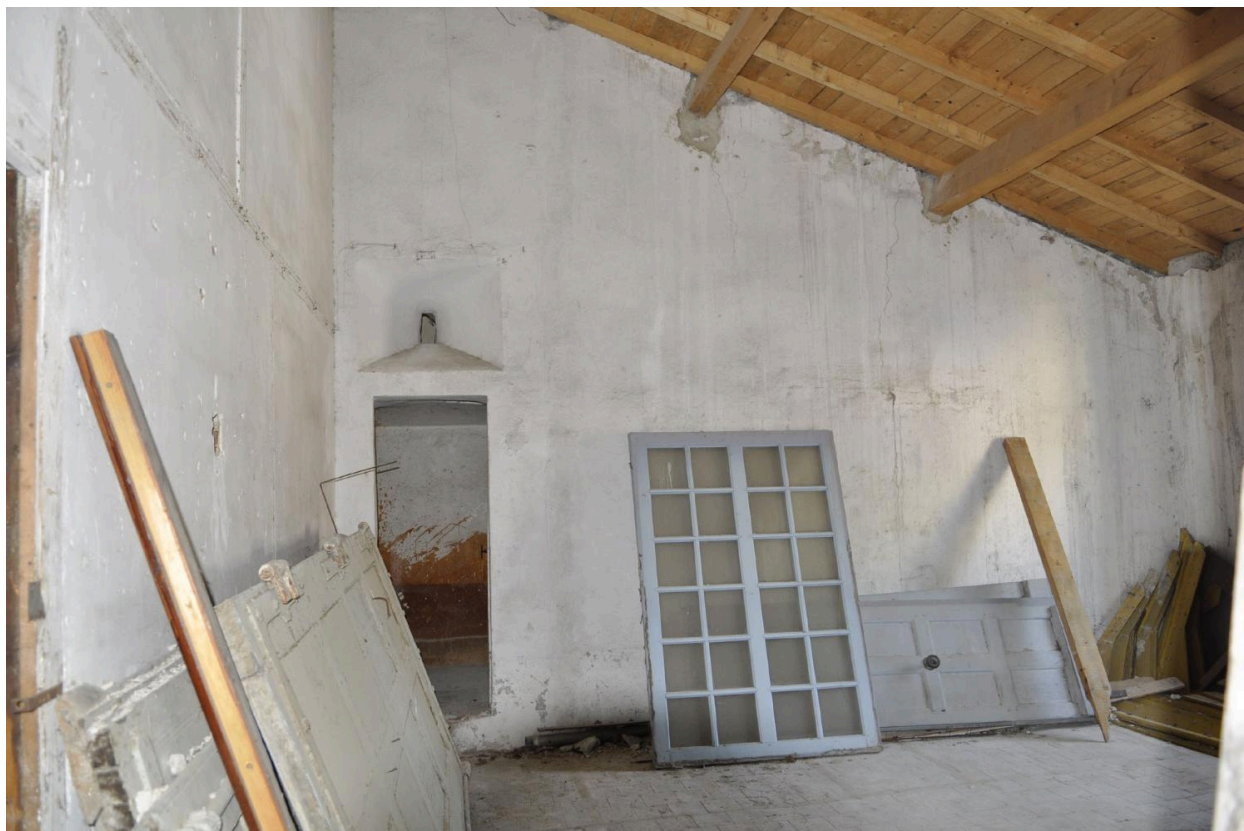
Comble (vue d'intérieur)
