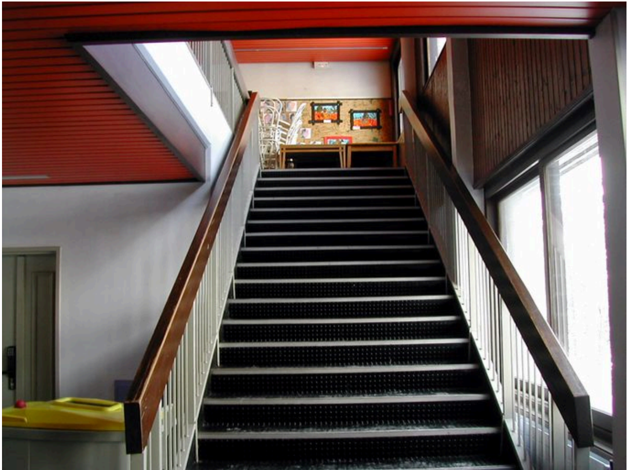
Escalier intérieur du bâtiment de l'école
