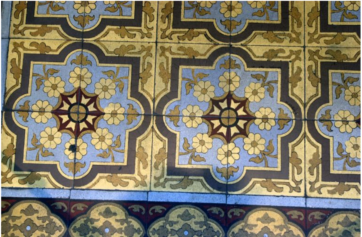
Carrelage de l'allée, détail
