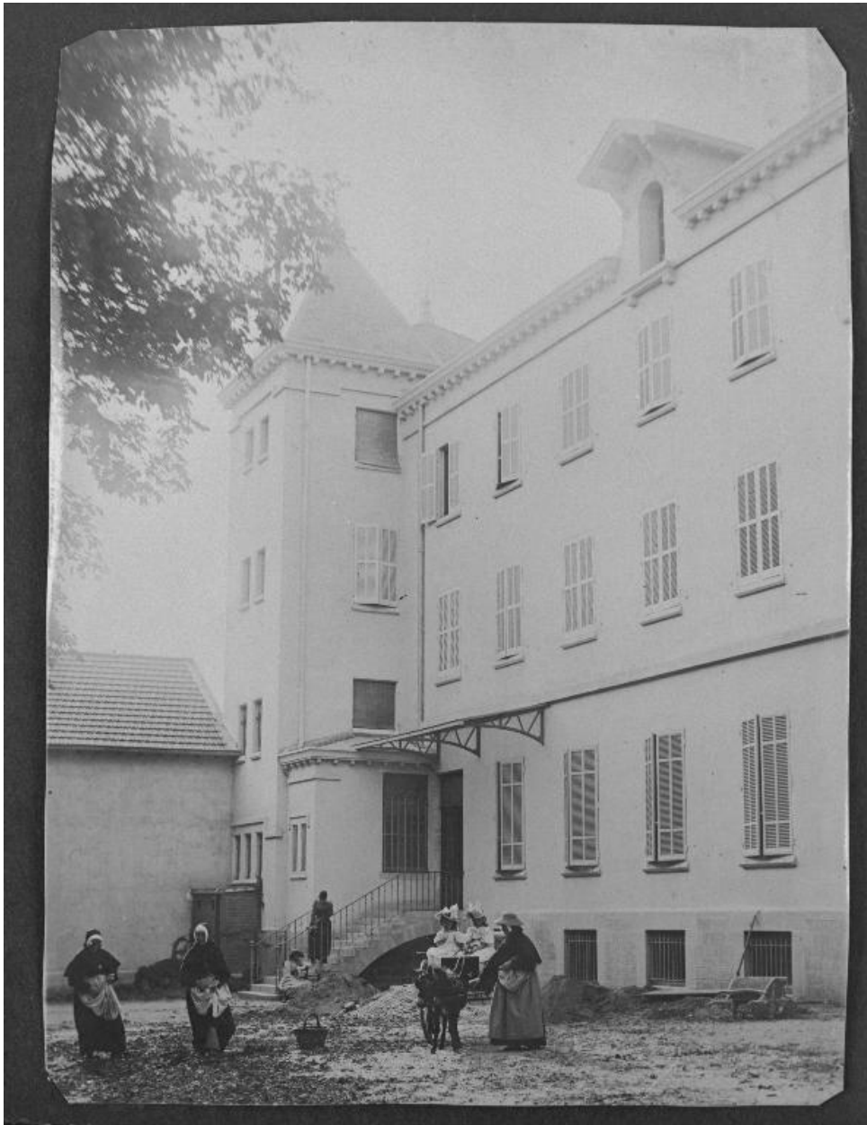
Elévation latérale de l'aile gauche. Photogr. [début XXe siècle].
