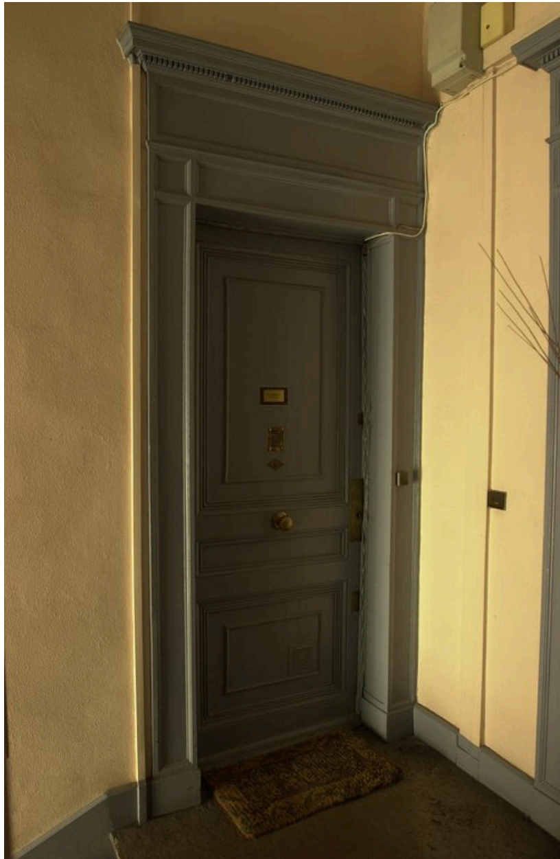
Porte palière d'un étage carré
