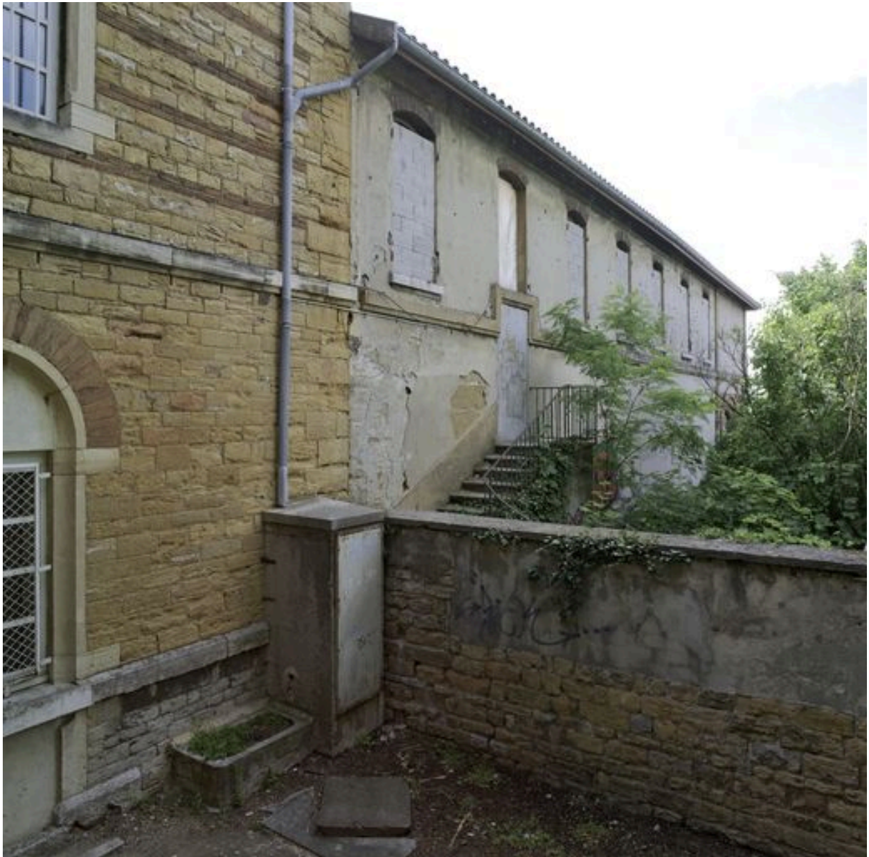
Gymnase, élévation postérieure depuis le nord
