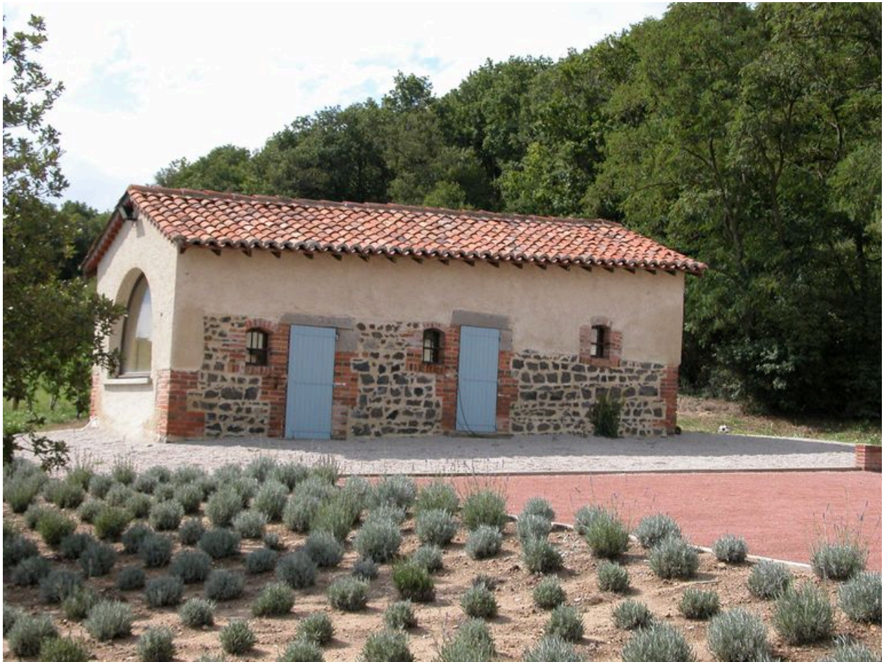
Vue de la dépendance isolée.
