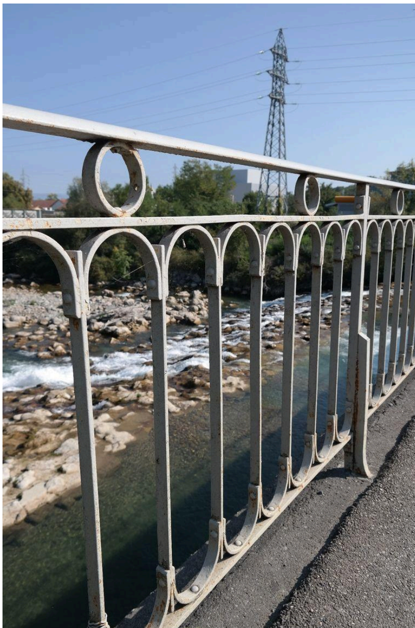
Pont de Dranse, détail des garde-corps
