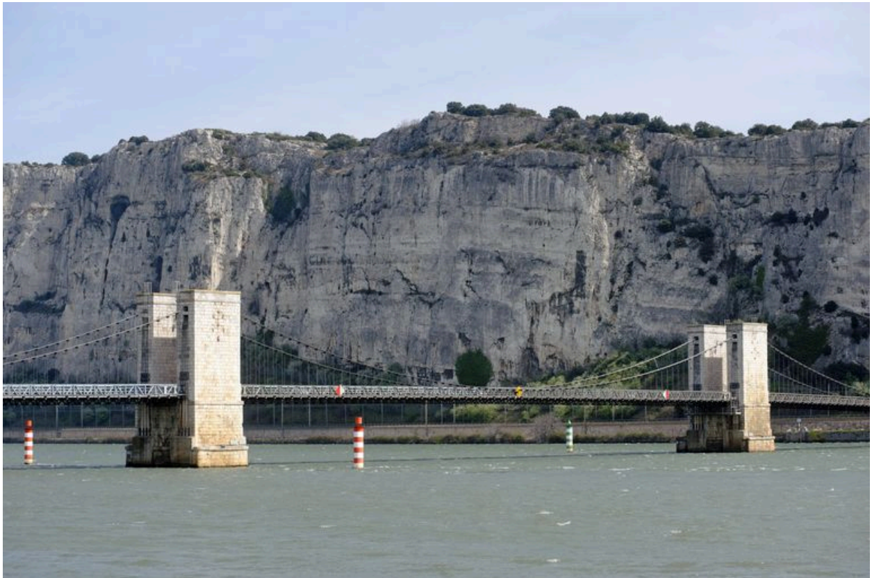
Vue de la travée centrale, côté aval
