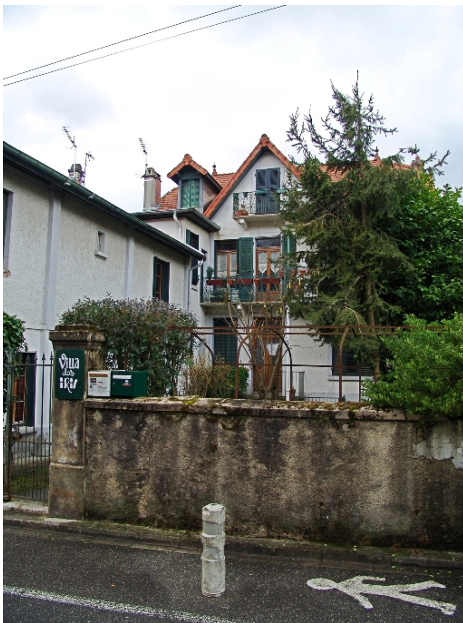
Façade antérieure sur cour
