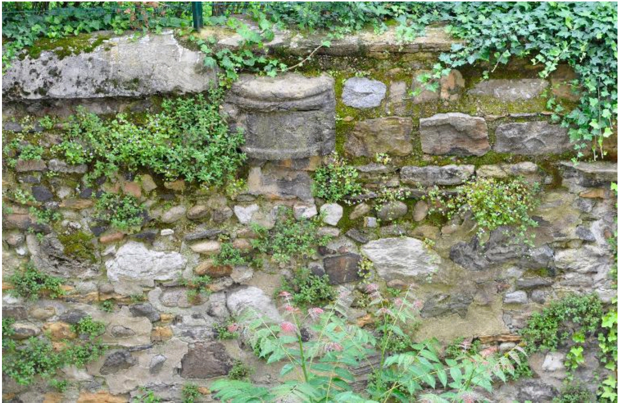
Détail du mur d'escarpe, à hauteur du 14 rue d'Austerlitz
