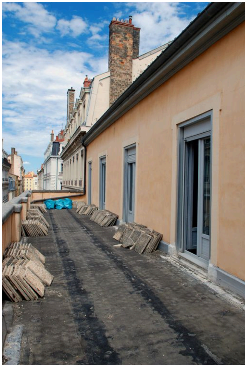
Elévation antérieure, quatrième étage, vue de la terrasse depuis le sud.
