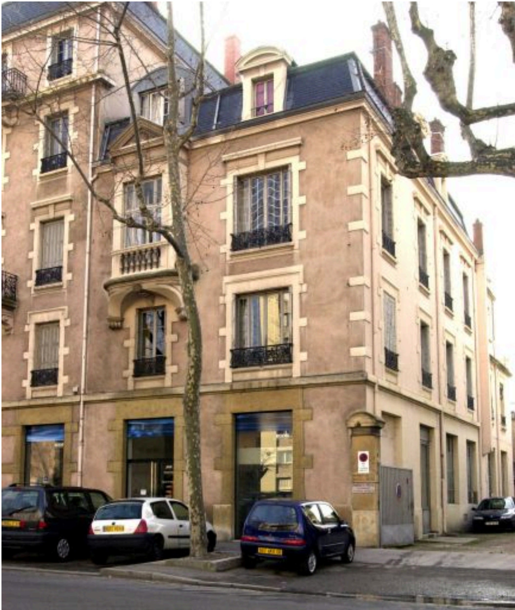
Façade principale, 16 cours Suchet
