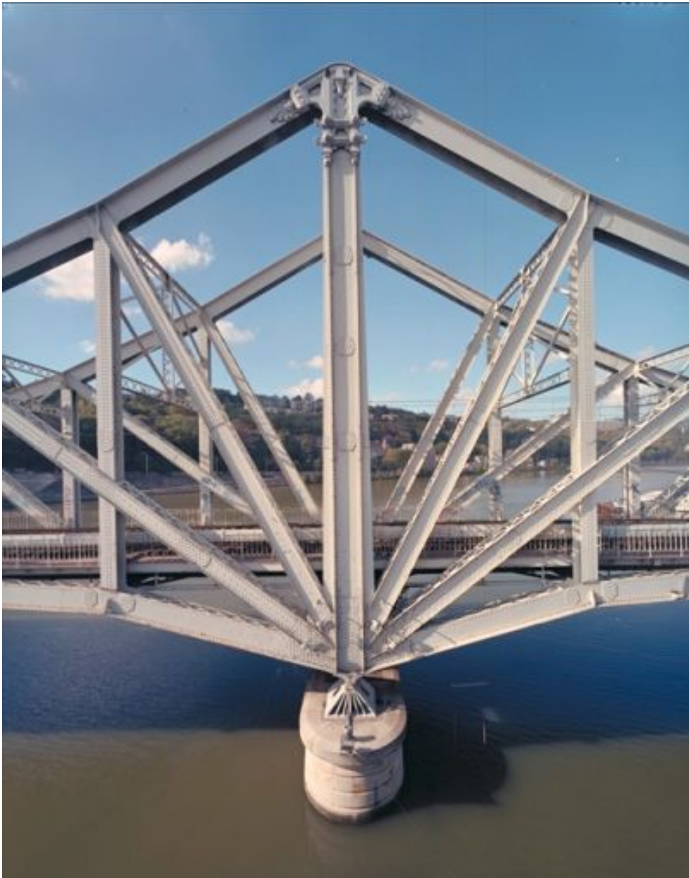
Détail d'une pile et d'un montant
