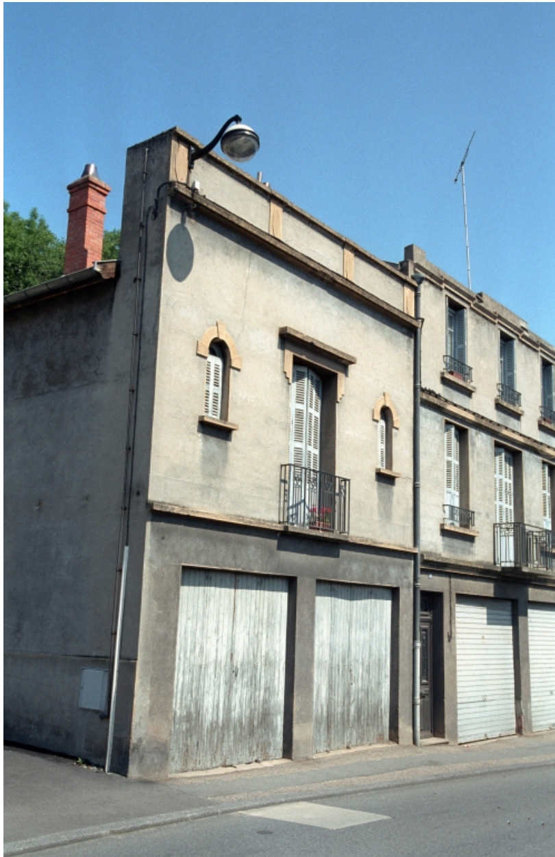
Boën, îlot 22, Lyon (rue de) 41. Vue générale de la façade sur rue.
