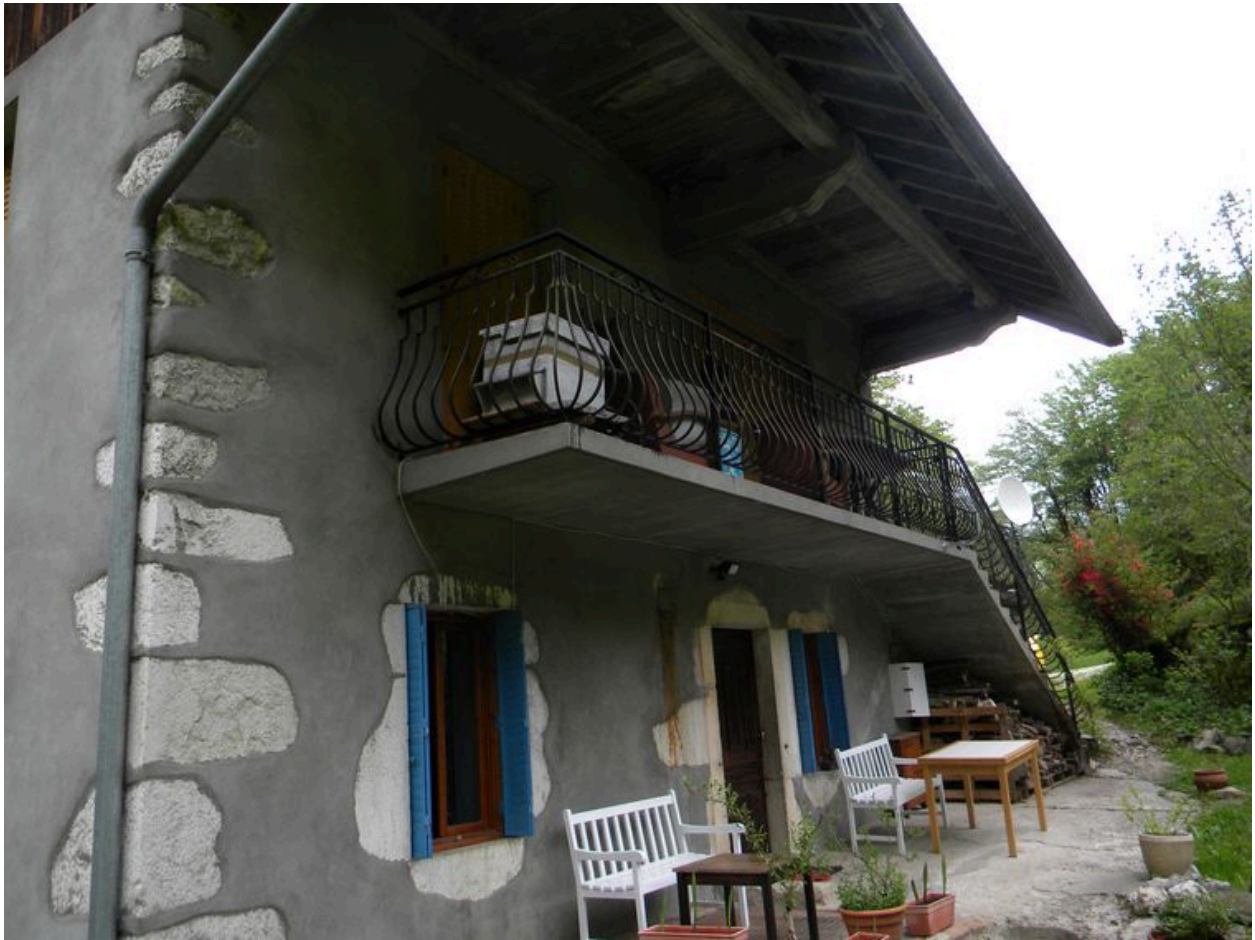
Vue générale de la façade principale du martinet.
