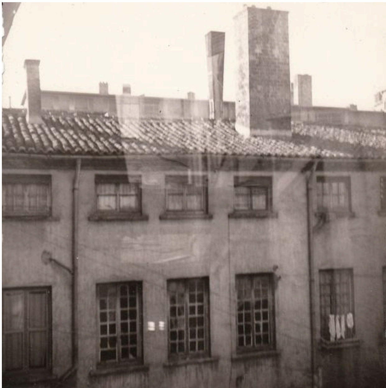
Elévation postérieure lors des travaux du bâtiment ISARA (2nd phase), photographie ancienne, 1972
