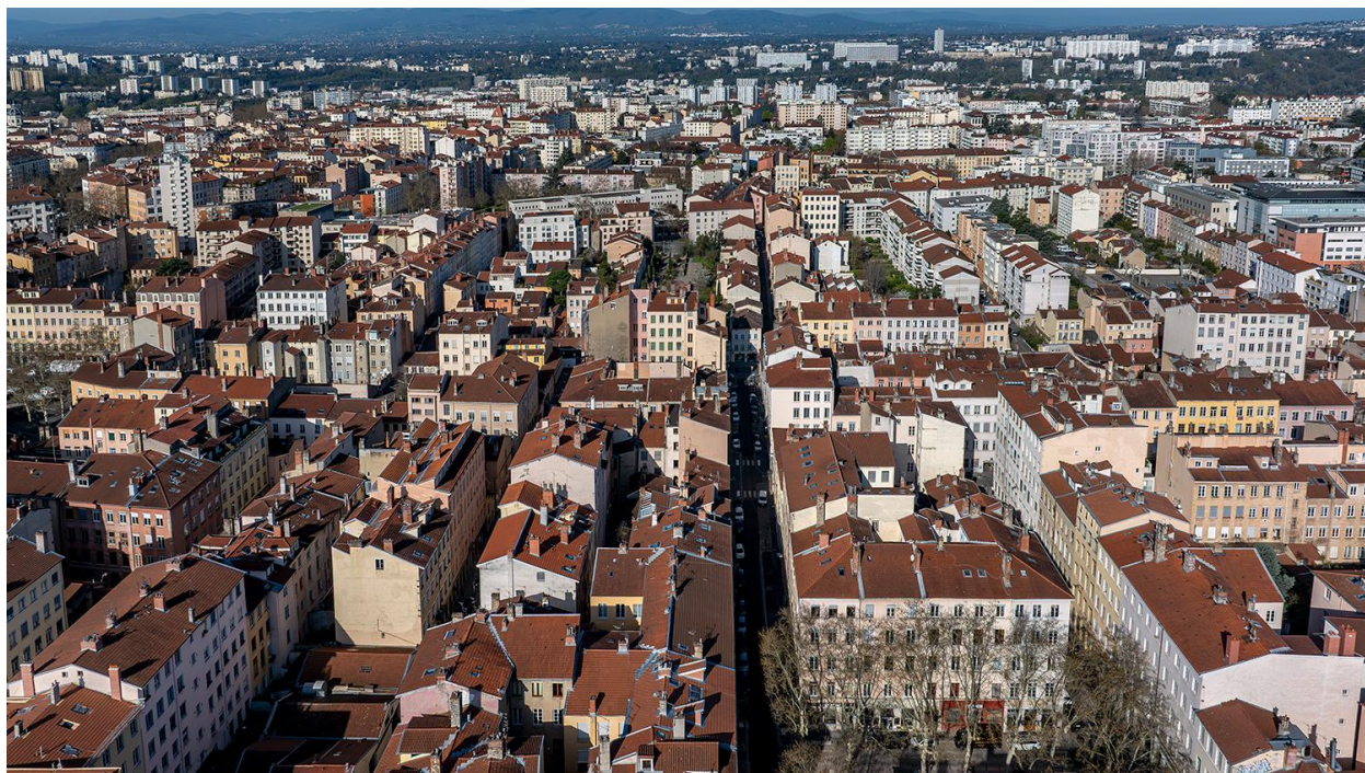
Vue d'ensemble secteur des immeubles-ateliers (vue drone)
