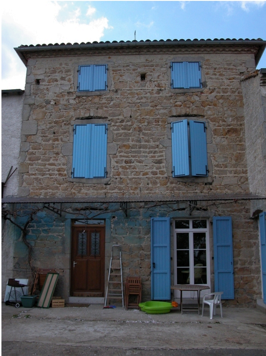
Ferme à l'Olme (chez Drutel), type A ? (non repérée, 1998 AE 97). Logis, sur cour.
