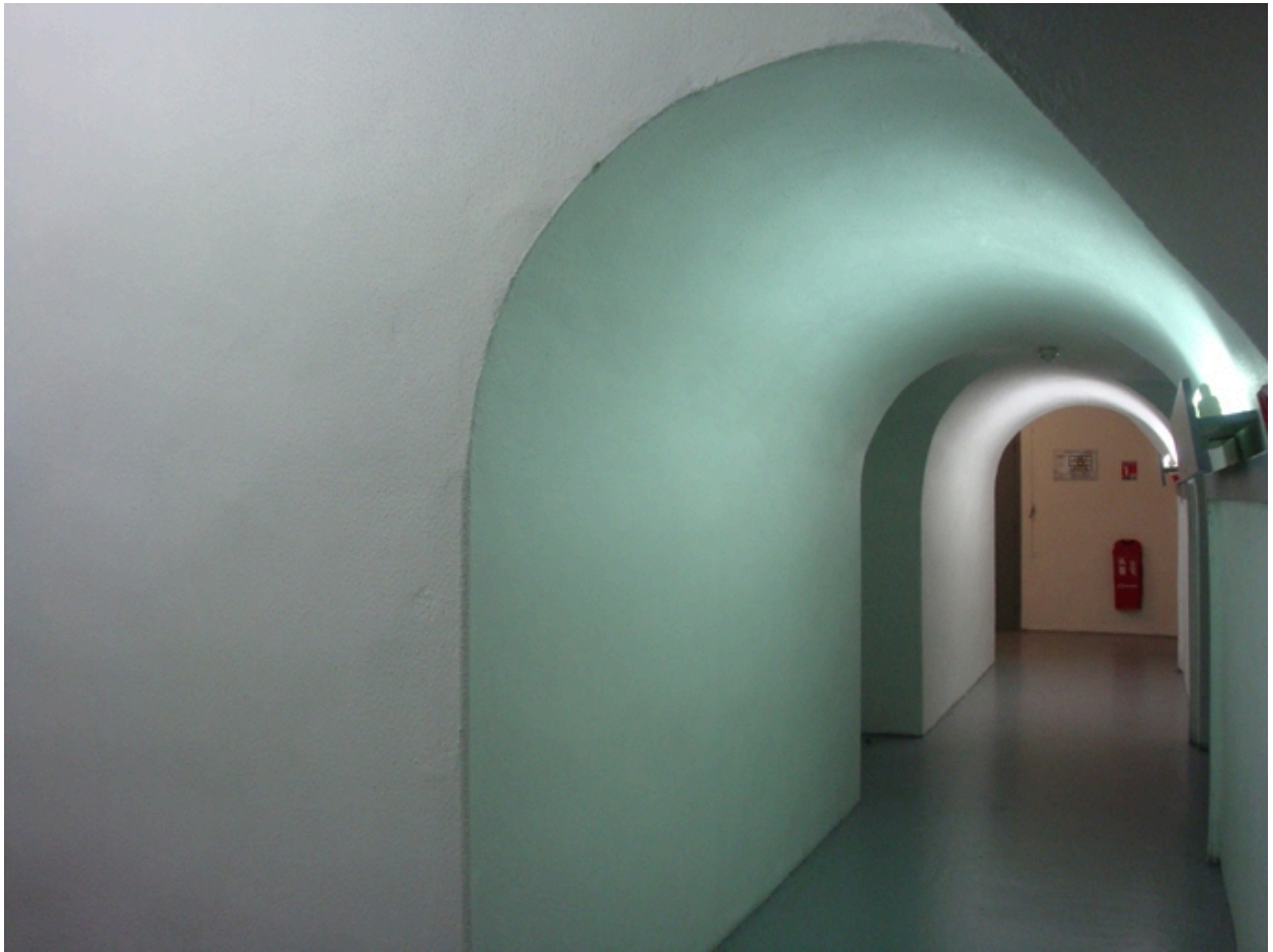
Détail voûtes, sous sol
