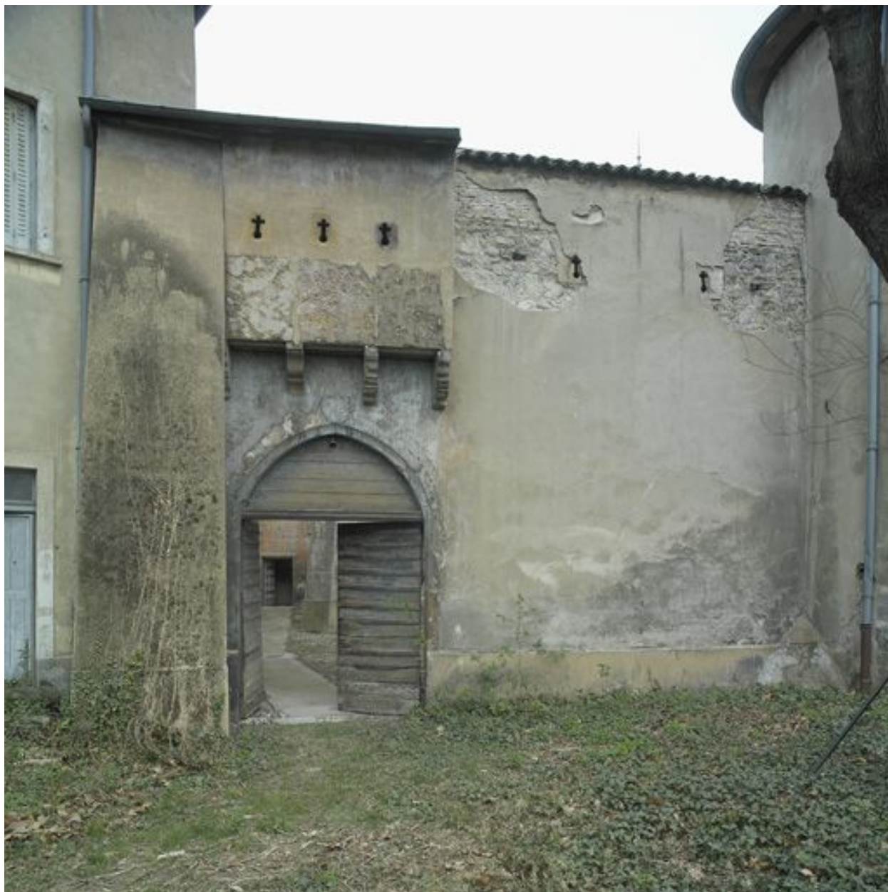
L'entrée du château
