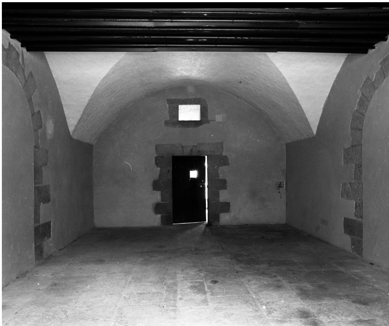
Bâtiment F (démoli), dortoir (ou cellule collective).
