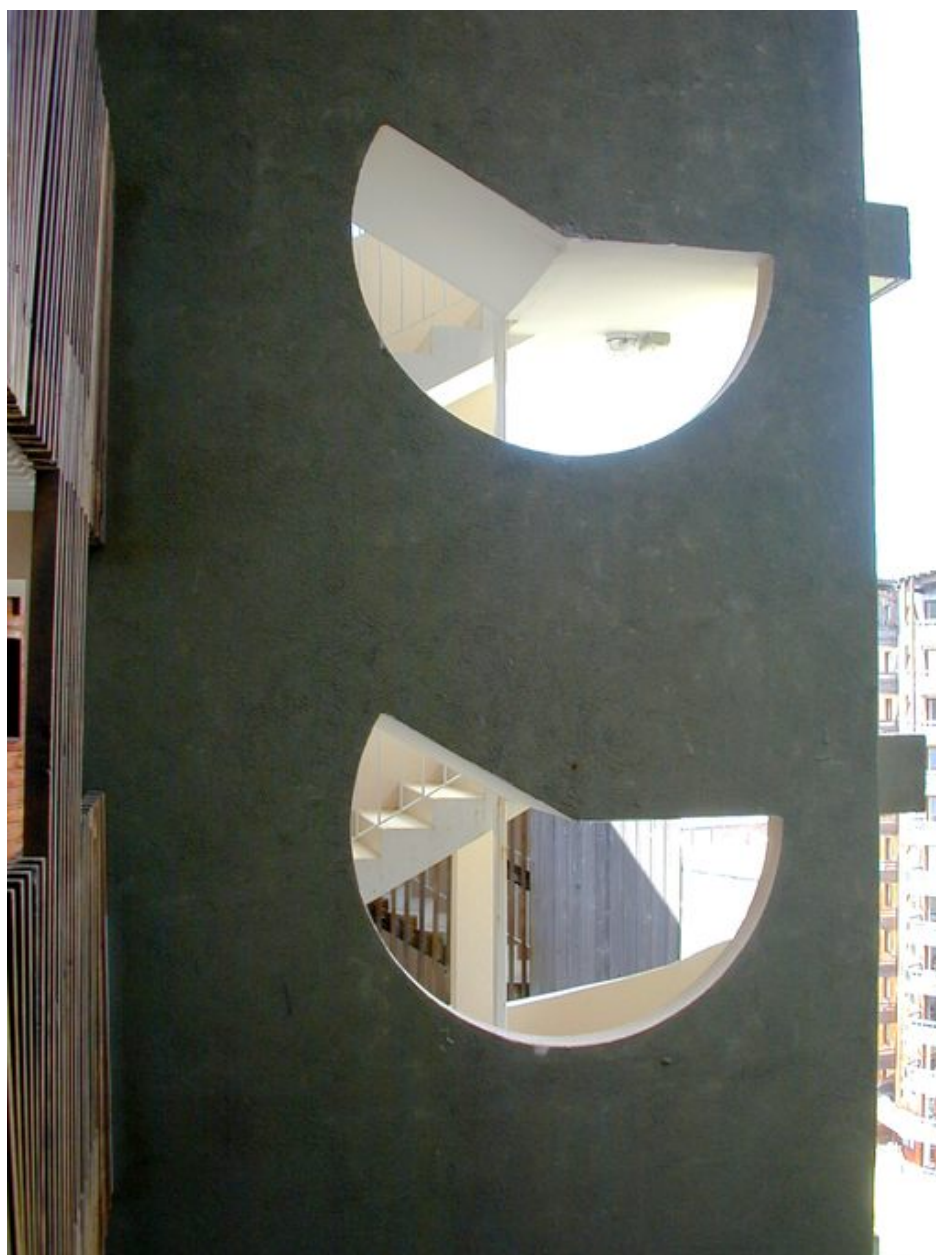
Détail des baies ouvertes d'une cage d'escalier
