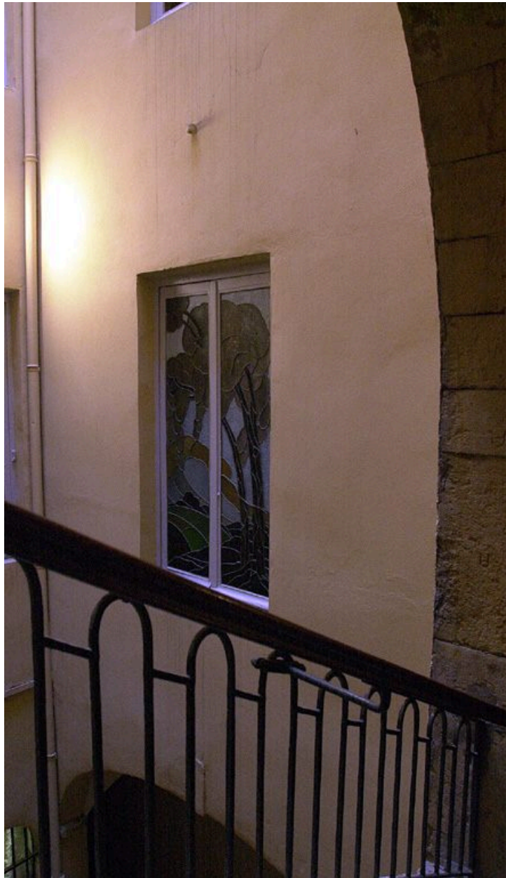
Corps de bâtiment côté quai : détail d'une fenêtre sur cour ornée d'un vitrail
