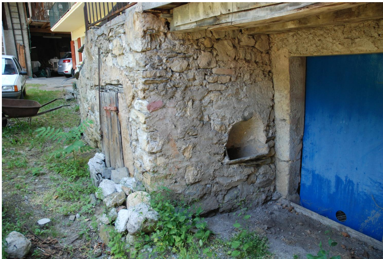
Détail de la loge à porc.
