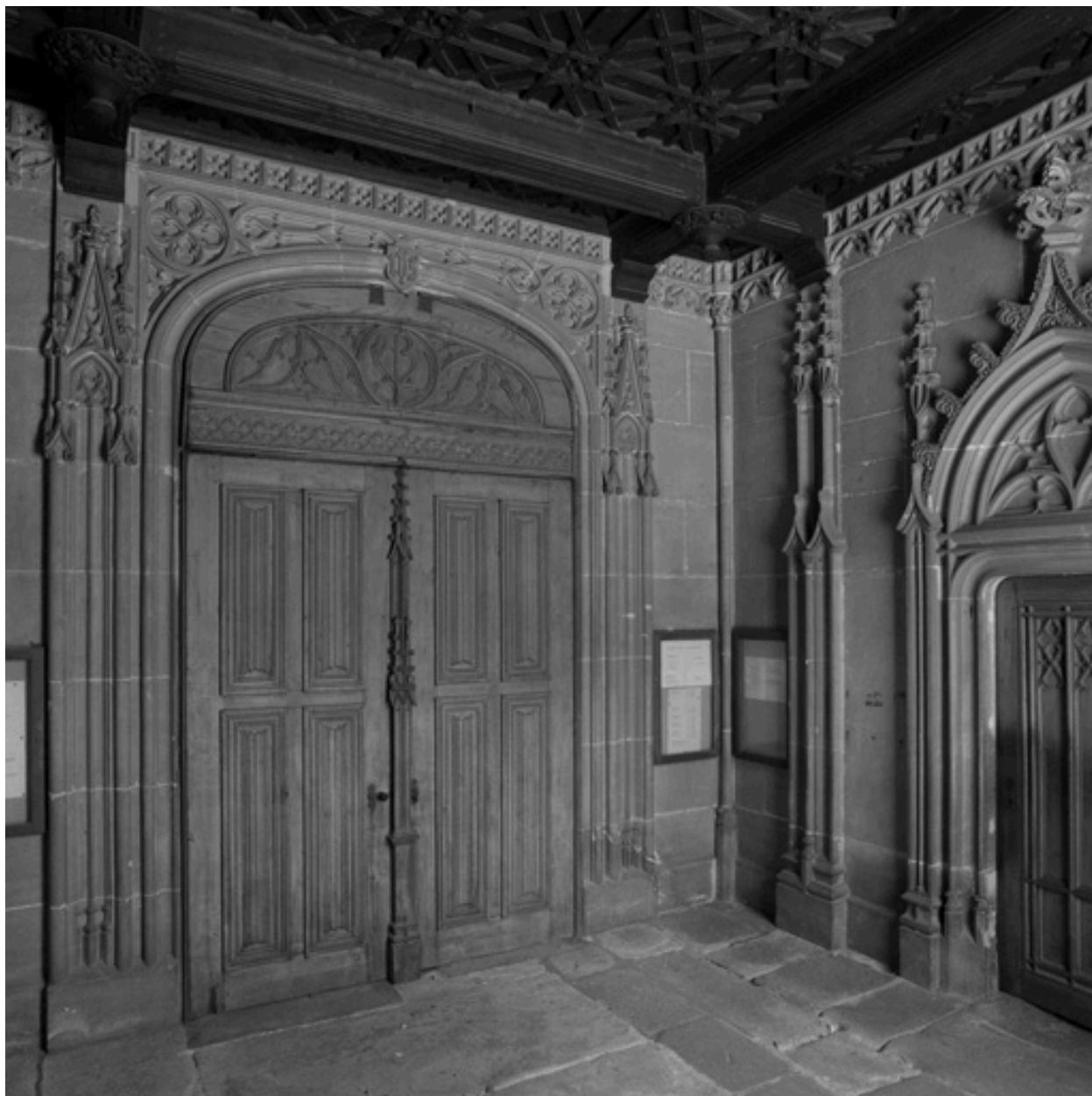
Vue d'ensemble de la porte axiale, de trois-quarts nord-ouest.
