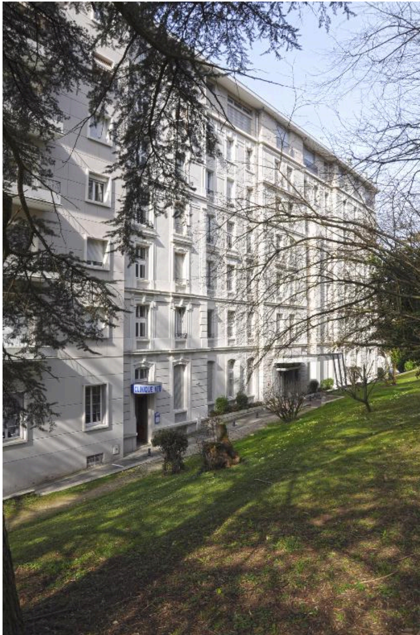
Façade postérieure (est)
