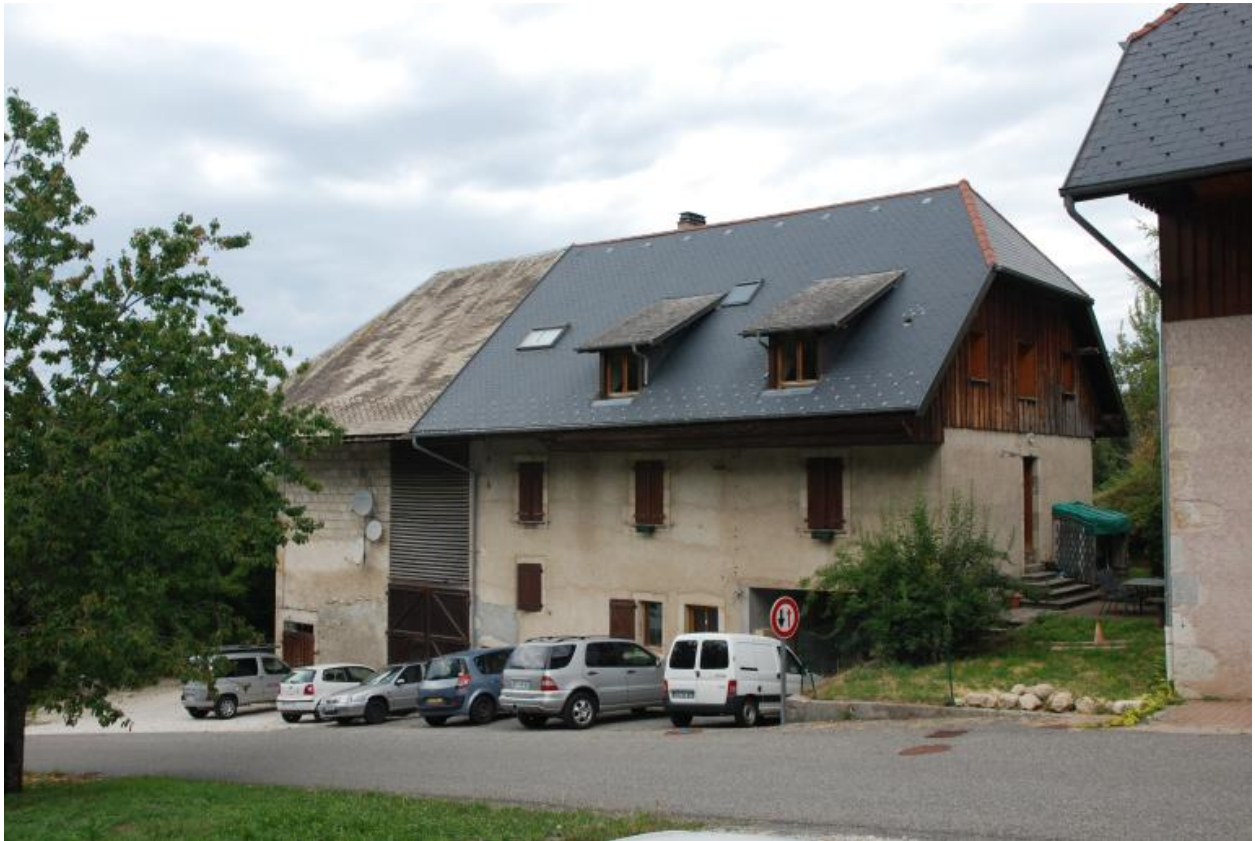
2016 C8 968, 2209, ferme. Vue d'ensemble de trois-quarts avant droit.
