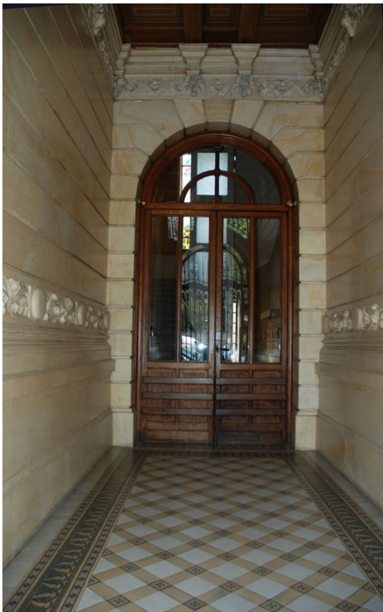
Le hall et la porte du sas, vus depuis l'entrée
