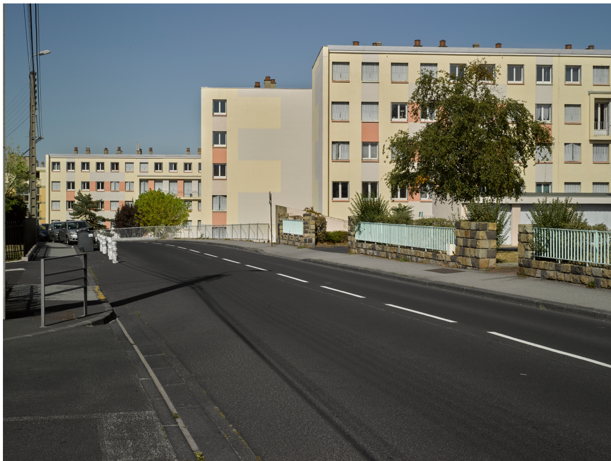
Ensemble d'immeubles collectifs, années 1956-1960 (cité de Rochefeuille).
