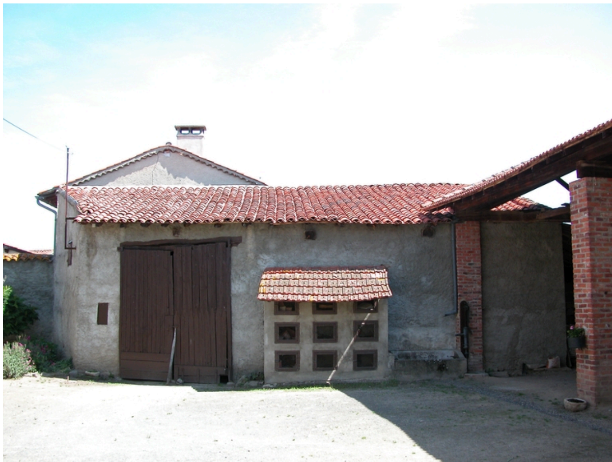
Vue de la grange.
