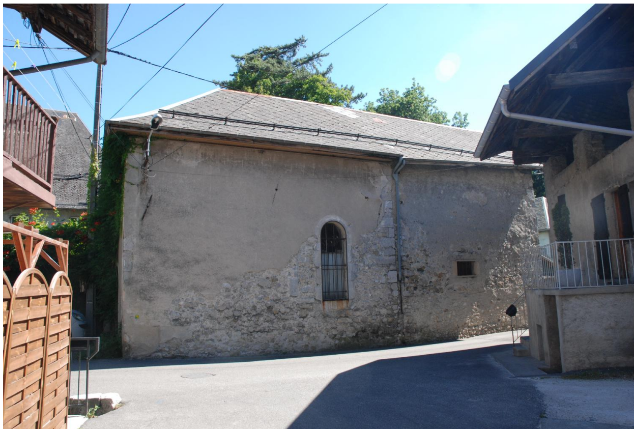
Vue de la chapelle (élévation nord).
