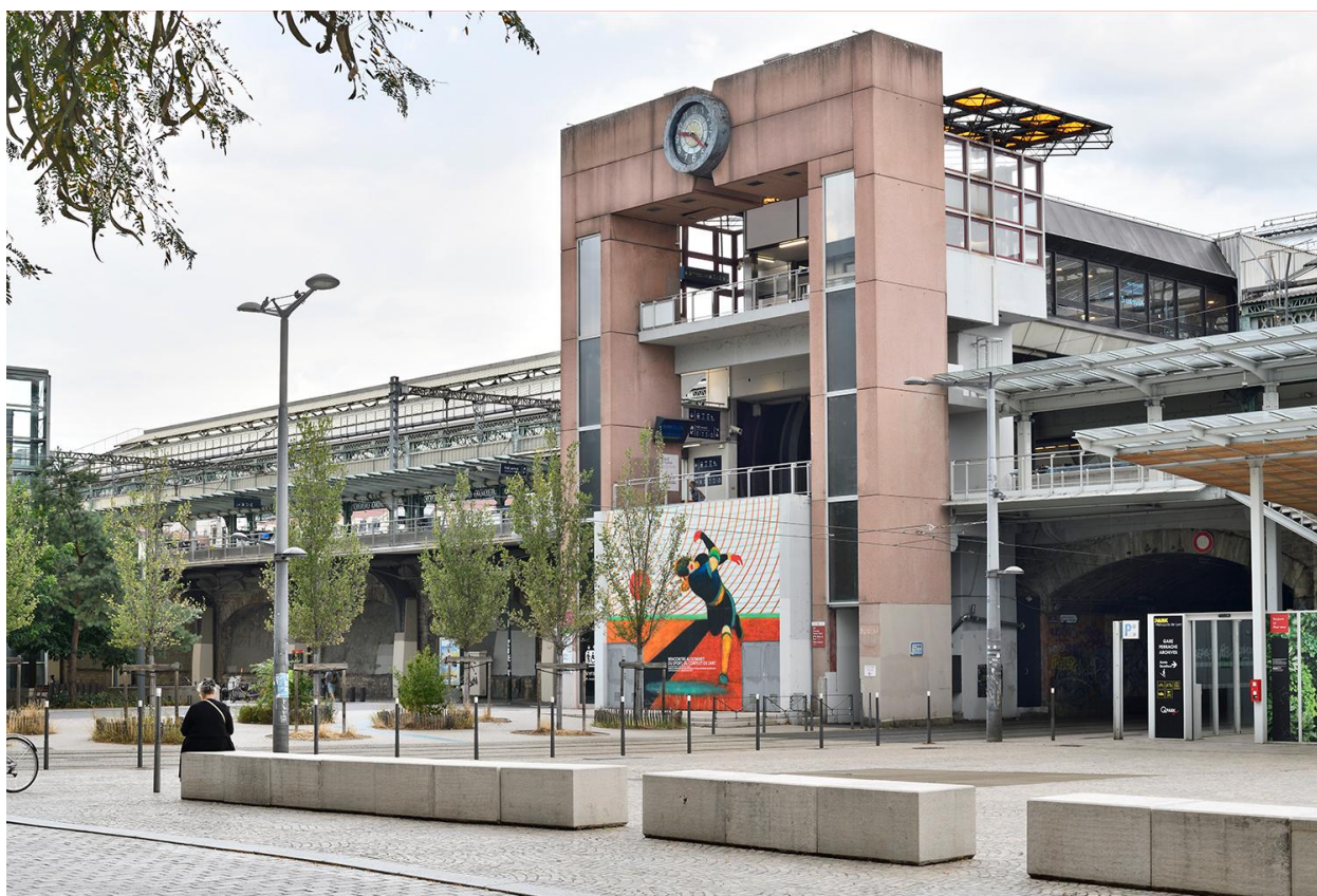
Été 2026 : la halle Saint-Etienne depuis le cours Charlemagne
