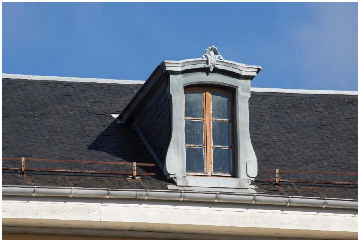
Cour 2 : lucarne sur bâtiment est.
