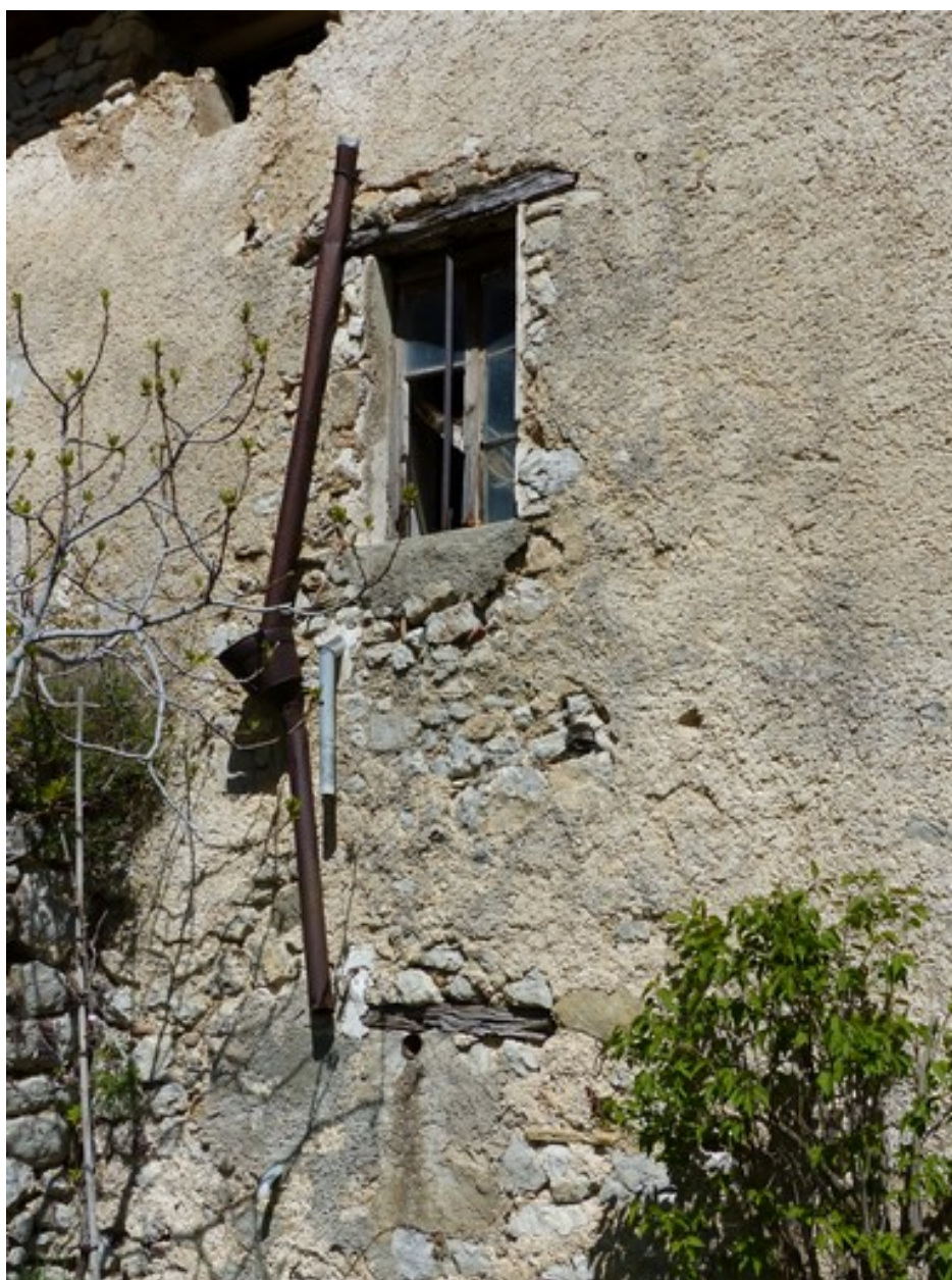
Ancien collecteur des eaux pluviales pour une citerne, ferme au ravin du Riou.
