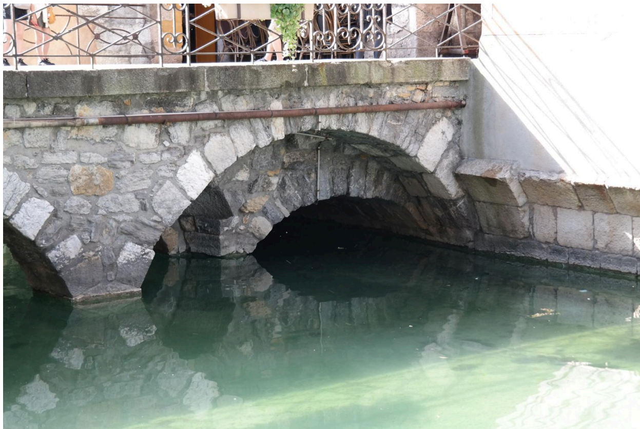
Pont Morens, détail de la voûte rive gauche face aval
