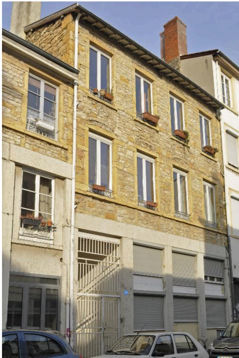
immeuble sur rue, élévation antérieure
