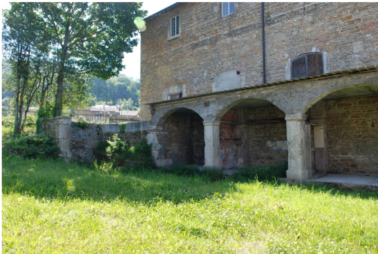
Détail niches et voie ferrée
