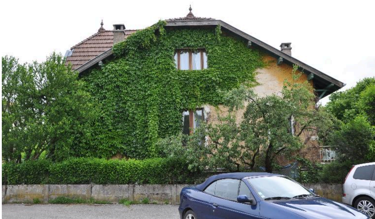
Elévation latérale sud
