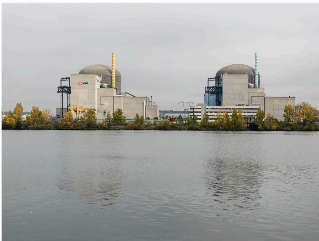
Vue ouest de la centrale nucléaire
