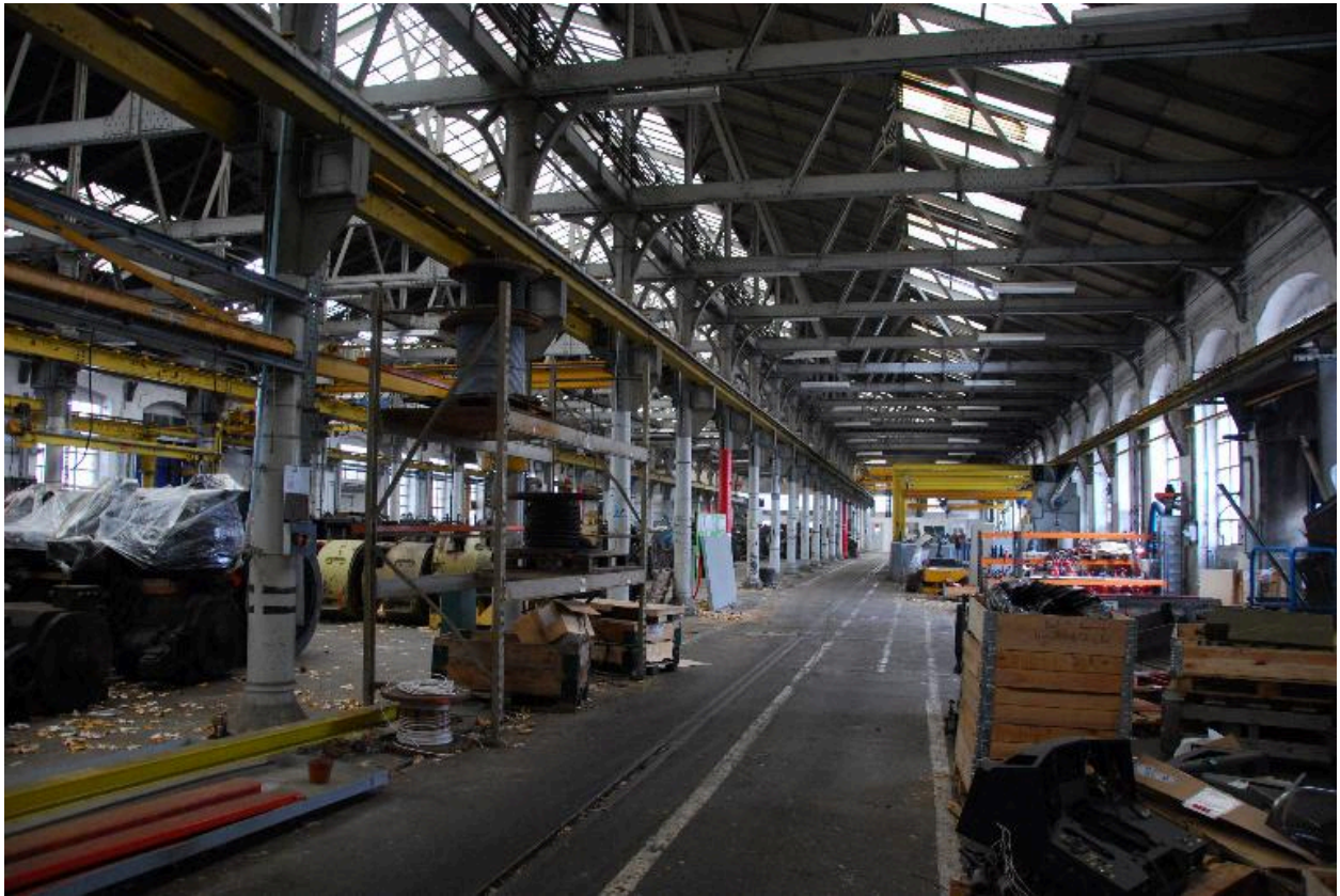
Vue intérieur de l'atelier bobinage
