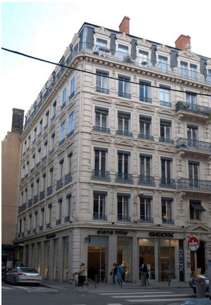
Vue de l'élévation latérale, rue Thomassin
