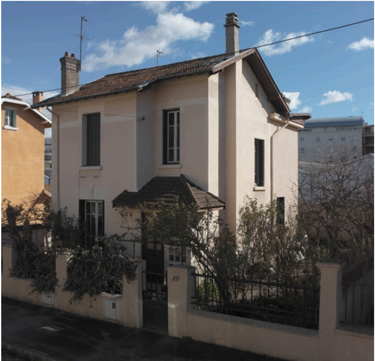
Vue sud-ouest, 27 rue Littré (BP 52), maison simple sur cour avec jardin, entrée sur angle rentrant façade principale
