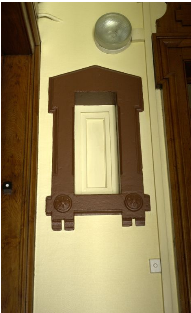
Petite fenêtre des WC ouvrant sur la cage d'escalier
