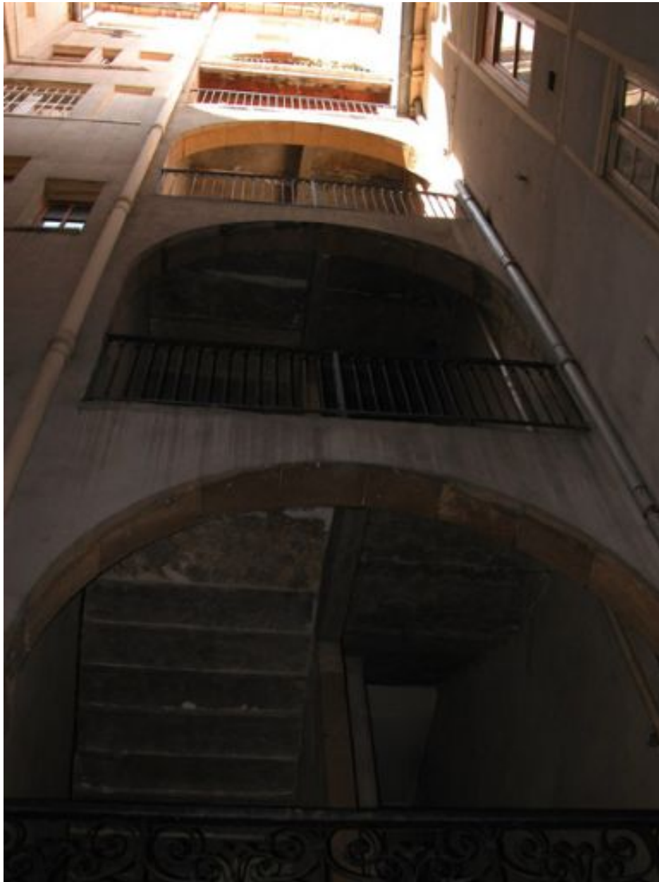
1ère cour, pavillon d'escalier
