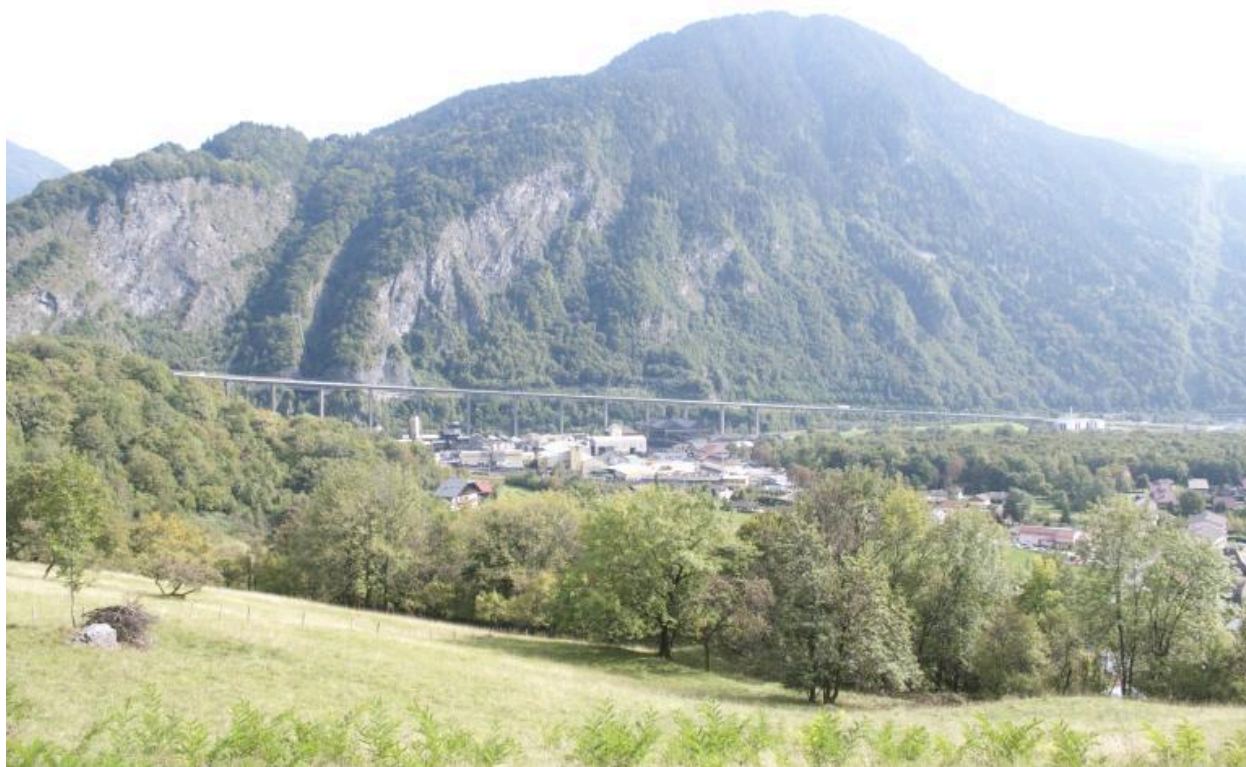
Vue générale de l'usine prise depuis le chef-lieu de Passy © Département Haute-Savoie - Cliché J. Laidebeur
