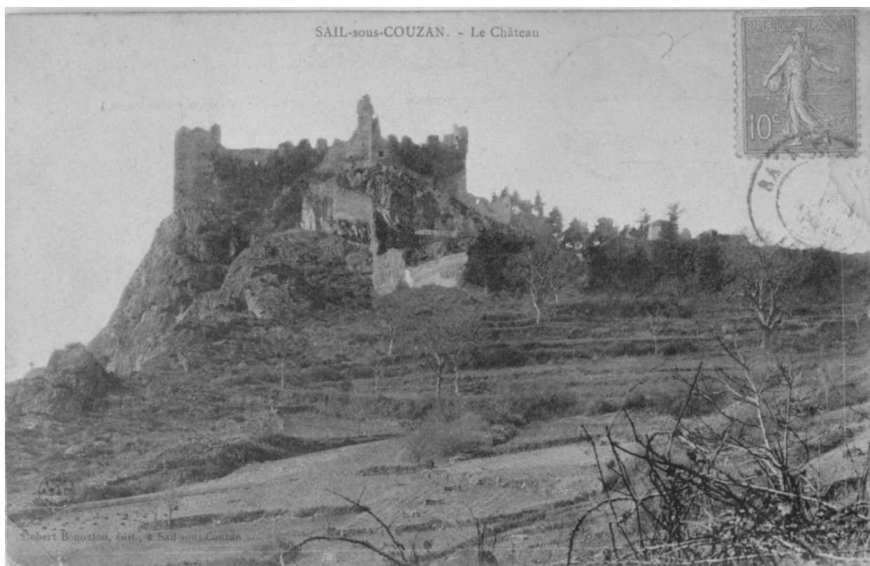
SAIL-sous-COUZAN. - Le Château. Robert Bonneton, édité., à Sail-sous-Couzan. PHOT AB & Cie NANCY. [Vue générale, de l'est.]
