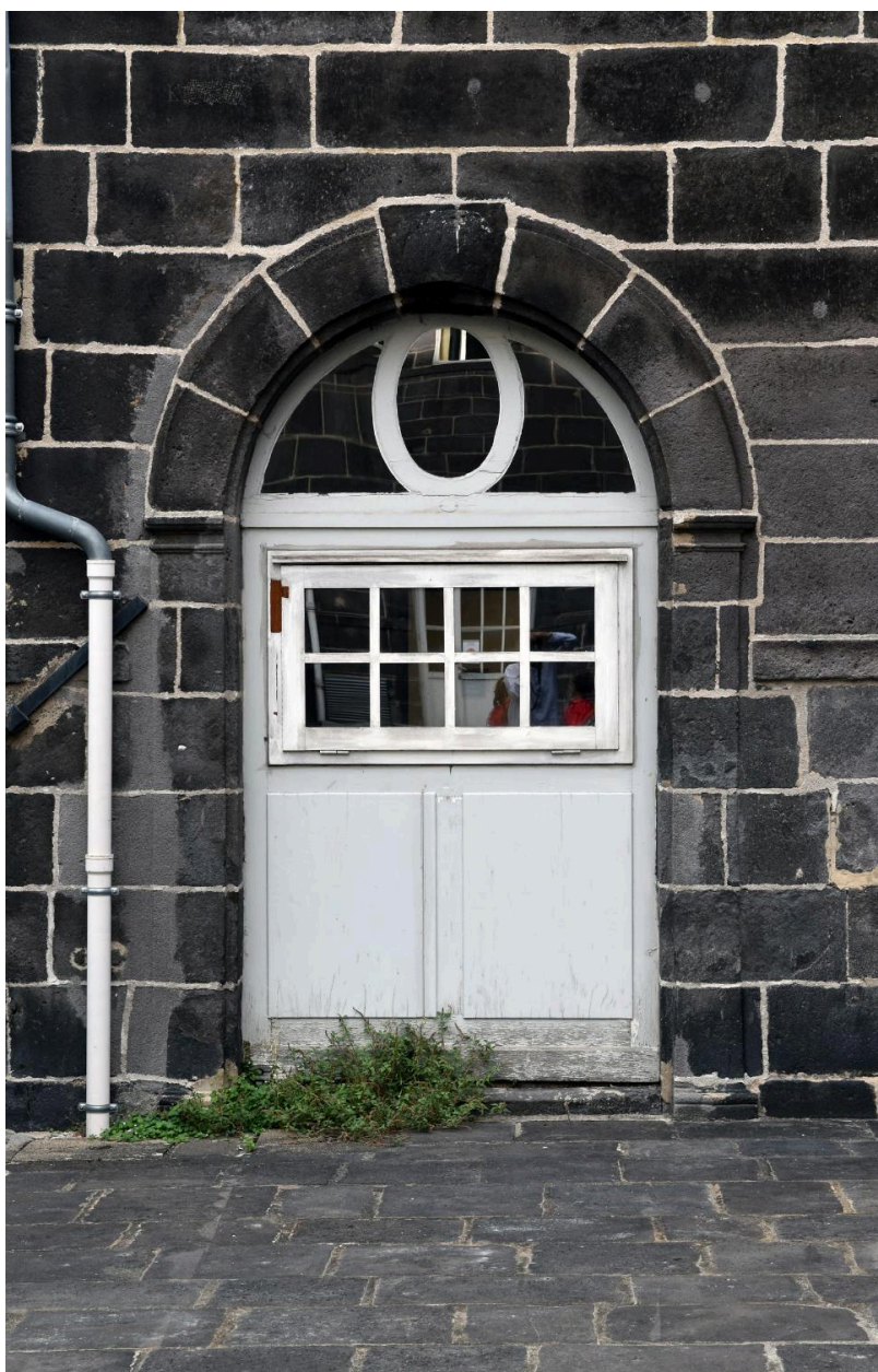
Bâtiment D : porte de l'ancienne chapelle des écoliers
