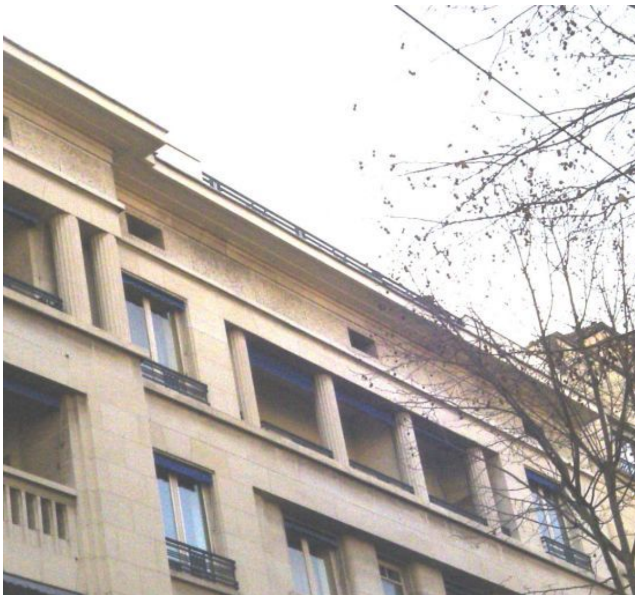
Vue de la loggia et du toit-terrasse
